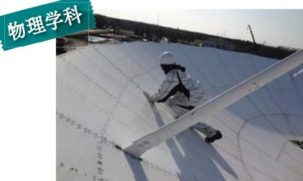
北大苫小牧研究林内の電波望遠鏡。宇宙物理学研究室の学生が鏡面を清掃しています。施設・装置の整備も研究活動の重要な一部です。
