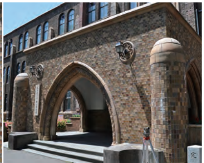
スクラッチタイルとテラコッタを組み合わせた茶褐色の外壁で覆われている
